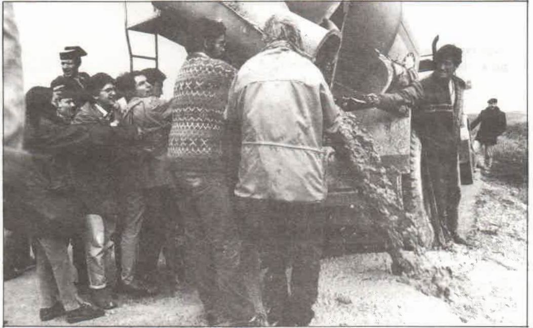
* 29-X-1985 : Ciudadanos se auto-encadenan a la maquinaria para impedir el hormigonado.
