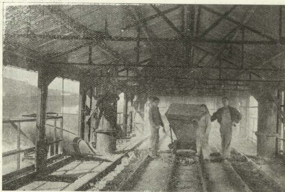
Antes se cargaban los hornos por medio de estas vagonetas, que habían de ser empujadas hasta la boca; como si dijéramos a brazo.
